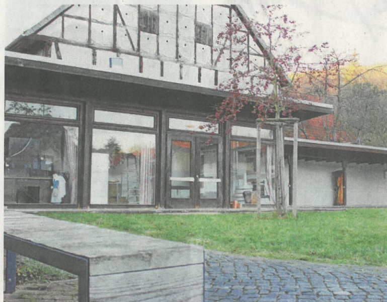
Die ehemalige Lesehalle am Kirchplatz in Steina.
