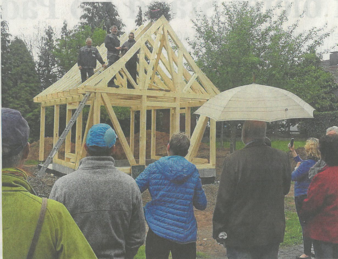
Der Zimmermann vollzieht den Richtspruch.
