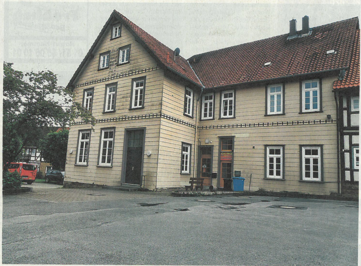
Gemeinde Bad Grund und Flecken Gittelde dürfen sich freuen: 41.000 Euro aus LEADER-Mitteln gibt es für den barrierefreien Umbau des Gemeindezentrums in der Schulstraße.
