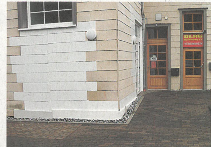
Die Außenfassade, wo die ehemalige Eingangstür war, wurde verschlossen, die Kosten hat die Gemeinde übernommen.
