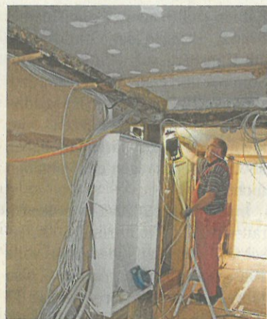
Kabelarbeiten. FOTO: BORDFELD / HK
