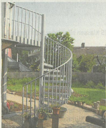
Die Fluchttreppe. FOTO: BORDFELD / HK
