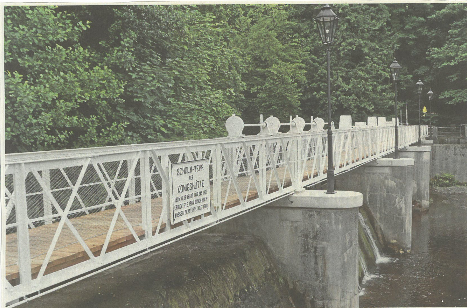
Die Scholmwehrbrücke ist nach rund zehn Monaten Bauzeit frisch saniert.
