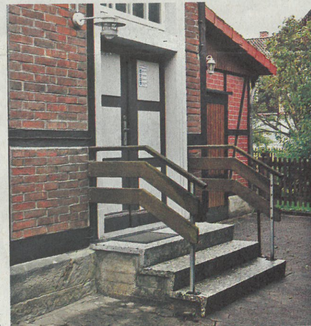
Das ehemalige Gemeindebüro im Eisdorfer Mitteldorf soll einen barrierefreien Zugang erhalten. FOTO: Petra Bordfeld
