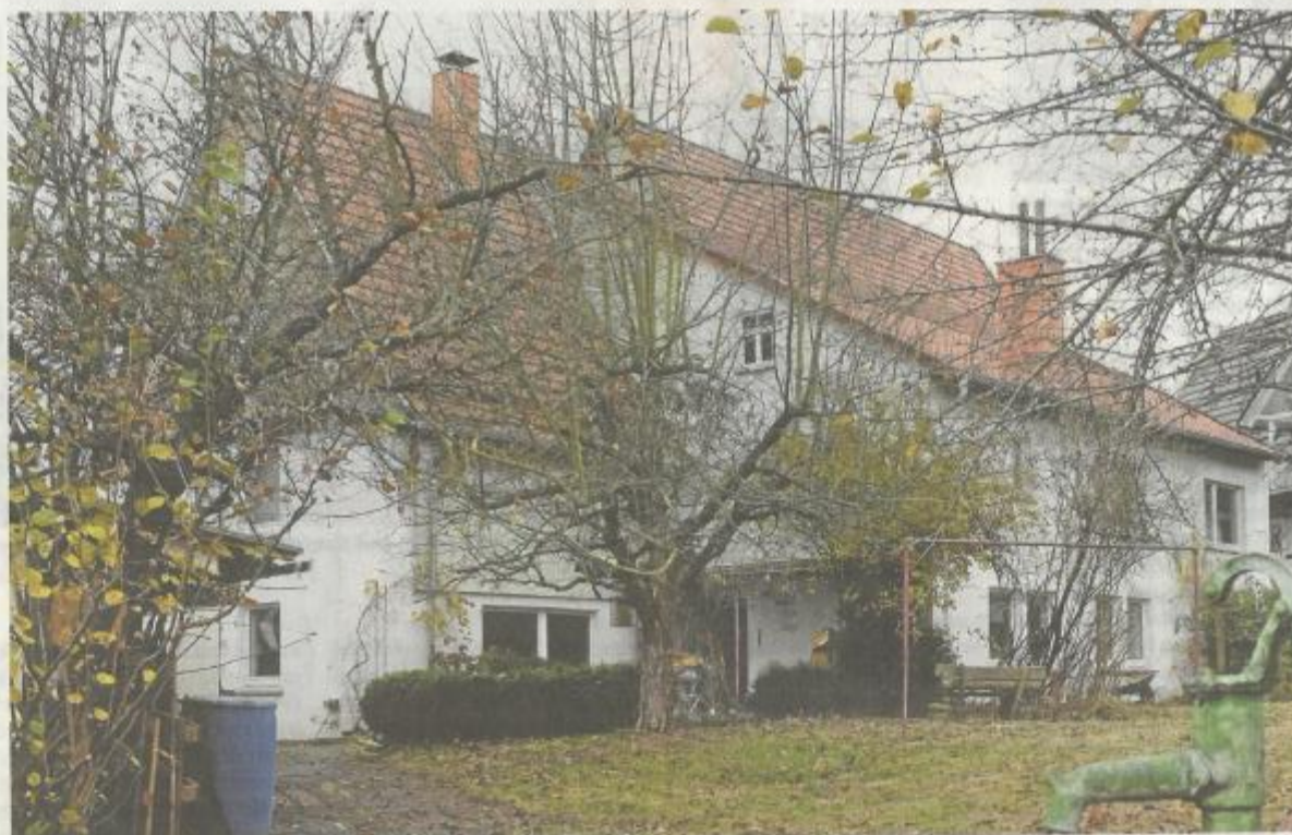
Die Dachsanierung des Dorfmuseums Meierhof in Hattorf wird durch Leader-Mittel gefördert.
